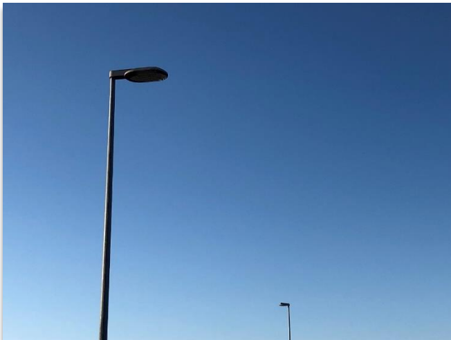
Figur 8 - Armaturer på Skolegade, Allingåbro
